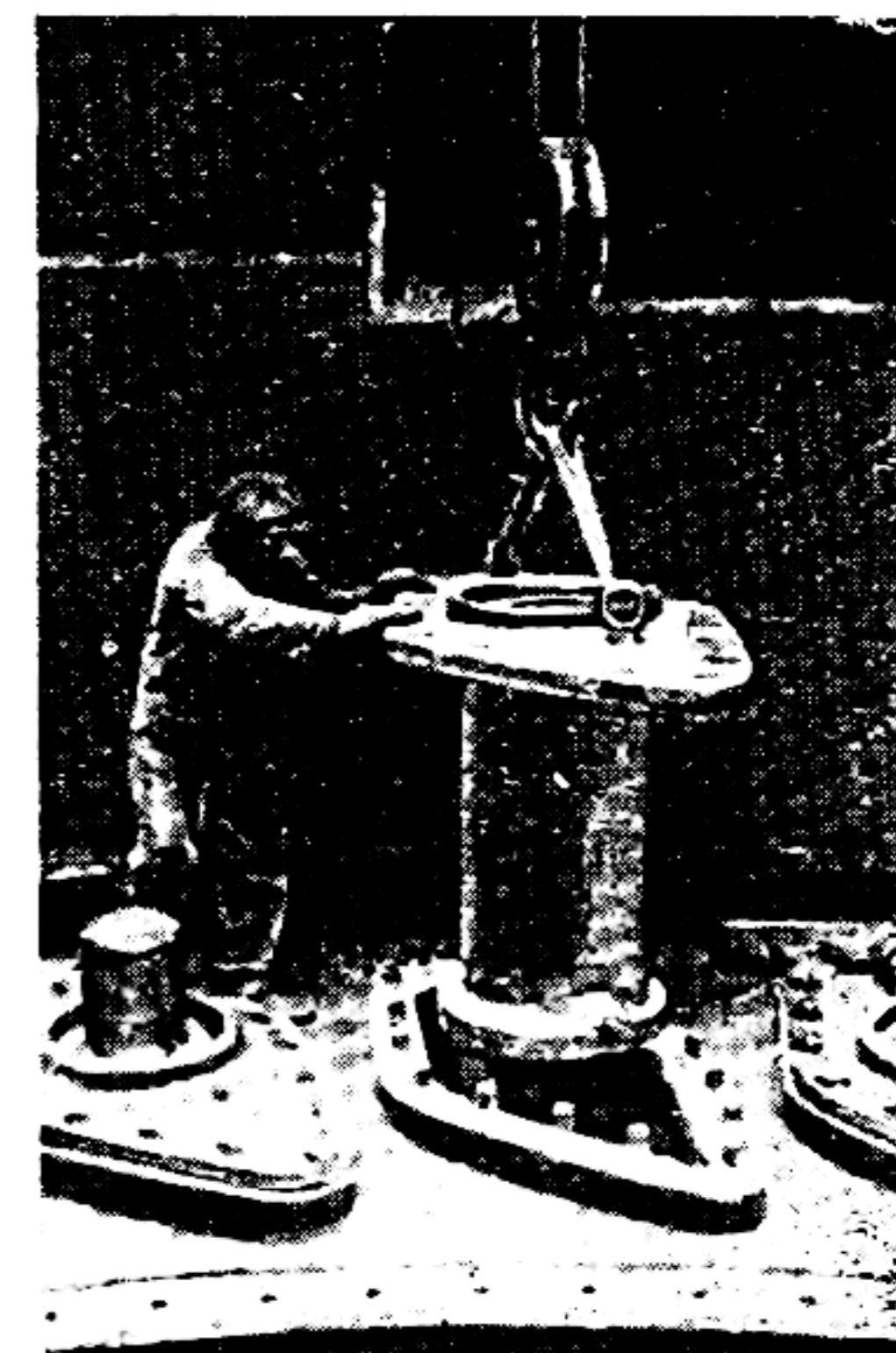
Rys. 102. Łożysko łopatek kierowniczej podczas jego wmontowywania przy pomocy wciągnika do górnego pierścienia kierownicy
