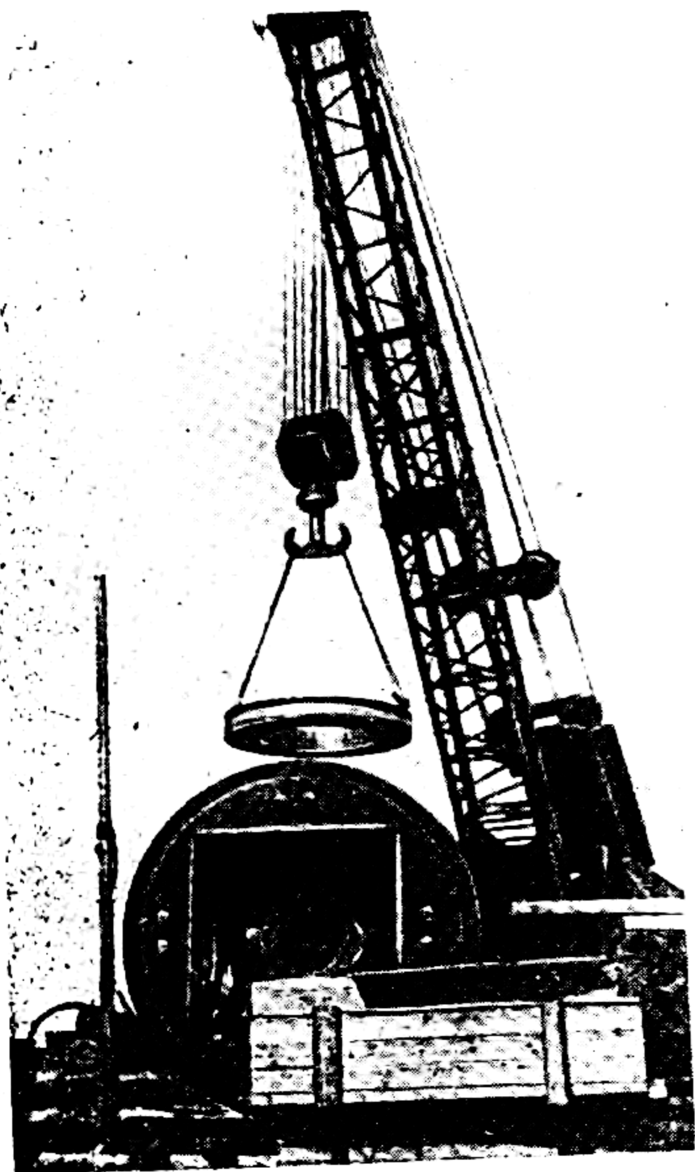
Rys. 100. Osadzanie pierścienia ustalającego w płaszczyźnie wirnika turbiny Kaplana
